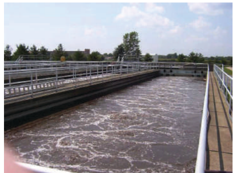
บ่อบำบัดน้ำเสีย
