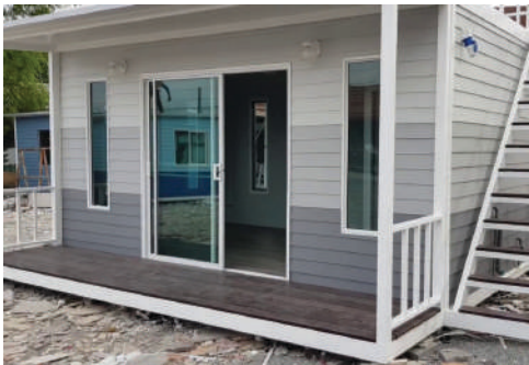
บ้านประกอบเสร็จ
